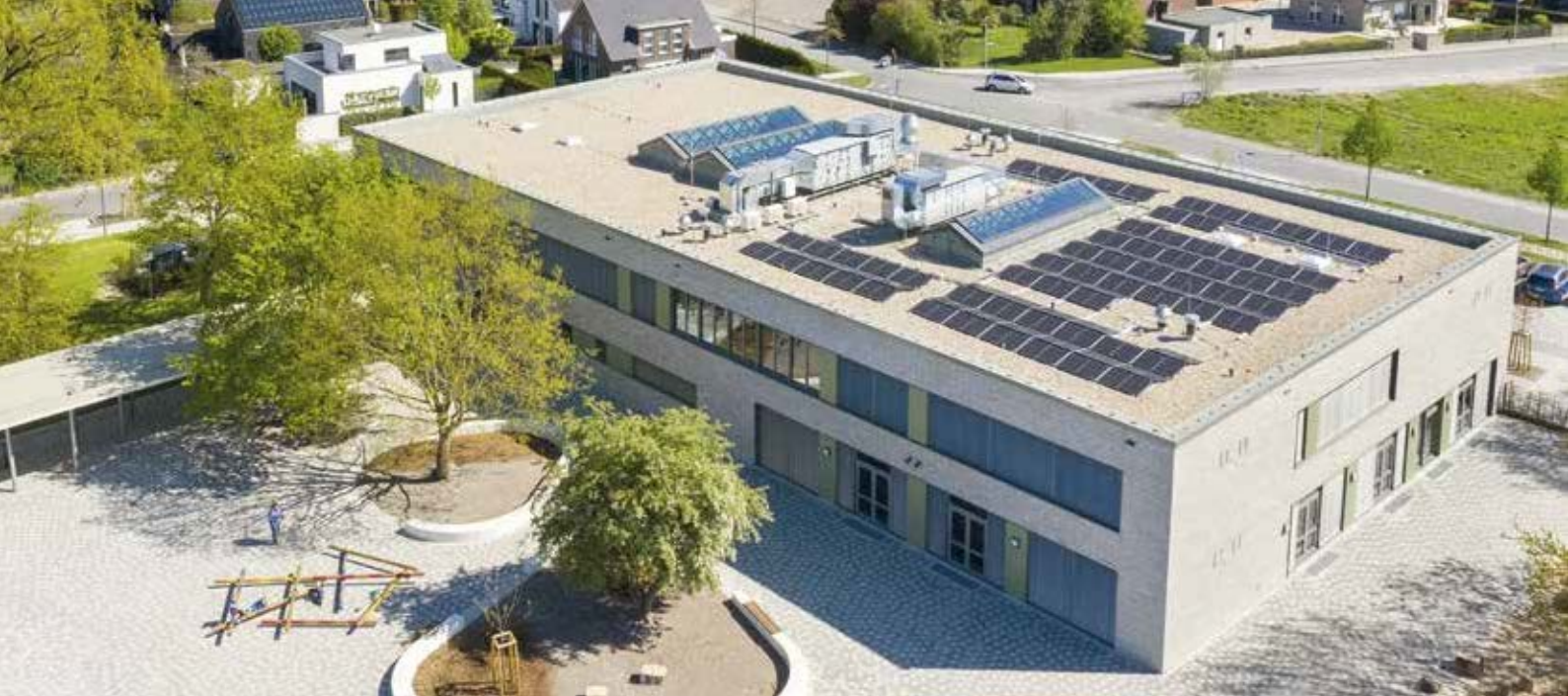
Neubau der Grundschule Wolbeck mit PV-Anlage
