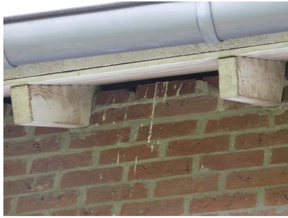
Brutplatz im Traufbereich zwischen Klinker und Holzverkleidung
