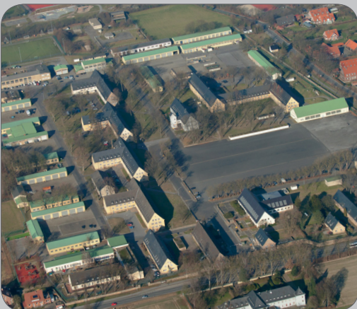
Die in den 30er Jahren erbaute Oxford-Kaserne im Schrägluftbild.
