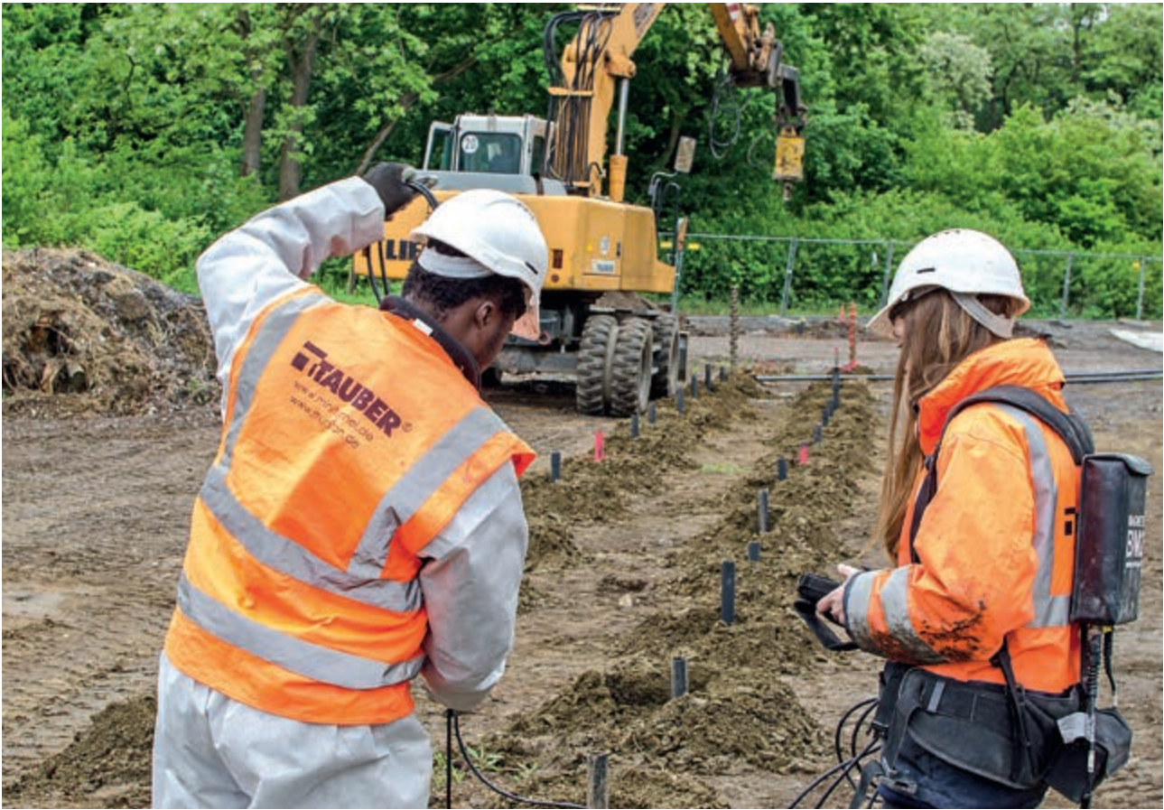
Detektionsmaßnahme an vorbereiteten Bohrlöchern
