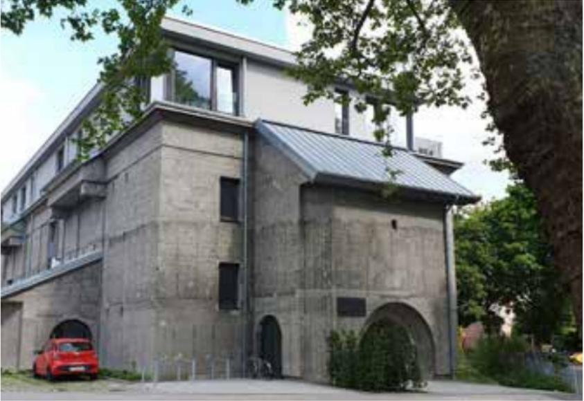
Nach den „Bestimmungen für den Bau von Luftschutz-Bunkern“ aus dem Jahr 1941 mussten Abschlussdecken für Bunker bis zu 1.500 Personen eine Mindestdicke von 2,5 m haben.
