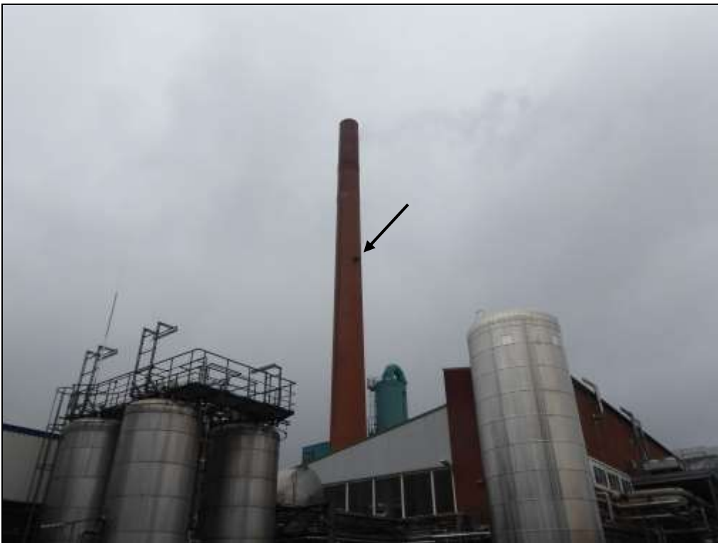
Abb. 6: Turm im Süden des Geltungsbereiches mit dem nach Osten ausgerichteten Wanderfalkenkasten (16.02.22)
