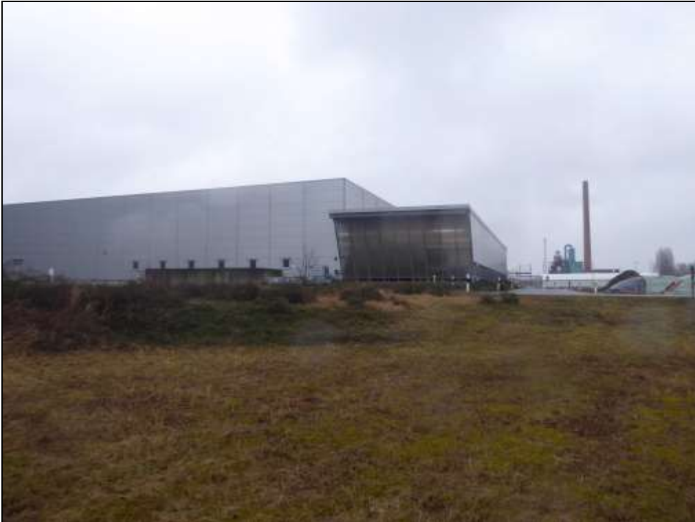
Abb. 10: Blick auf das Regenwasserrückhaltebecken im Süden des Geltungsbereiches (16.02.22)
