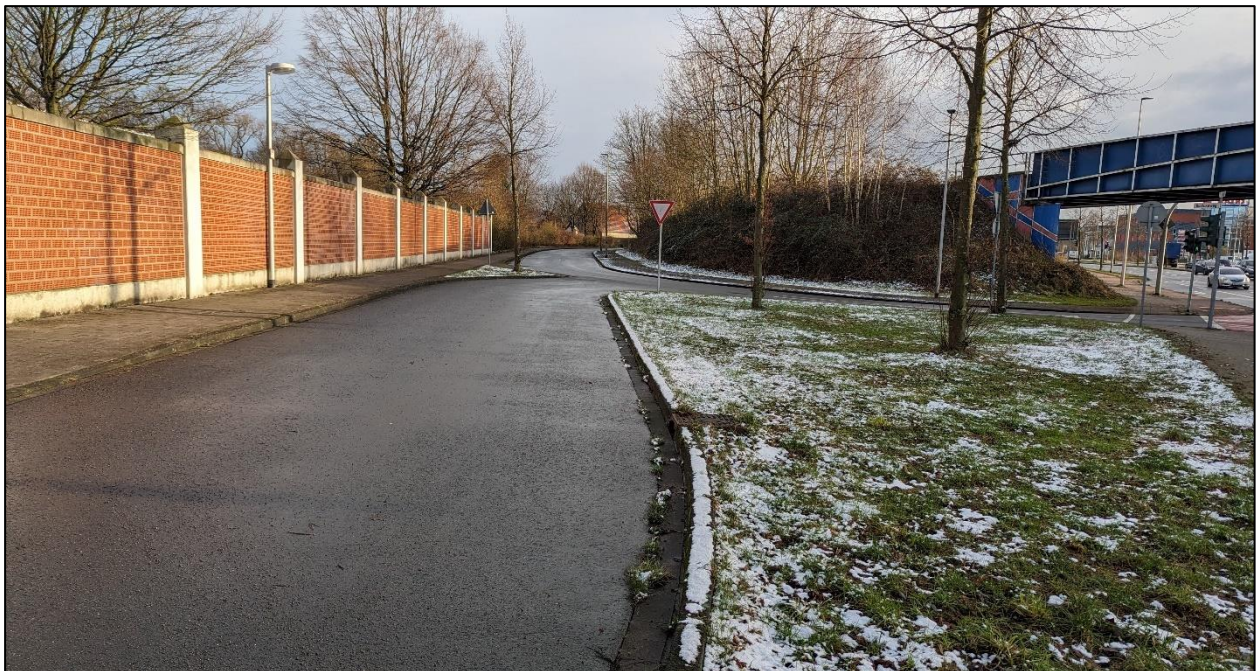
Abbildung 31: Zufahrt des Gasometers am Boelckeweg (eigene Aufnahme)
