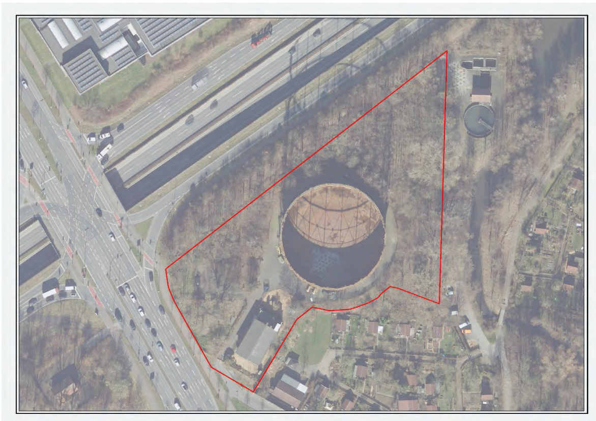
Abb. 2: Aktuelle Bestandssituation (Luftbild, rote Linie = B-Plangrenze)
