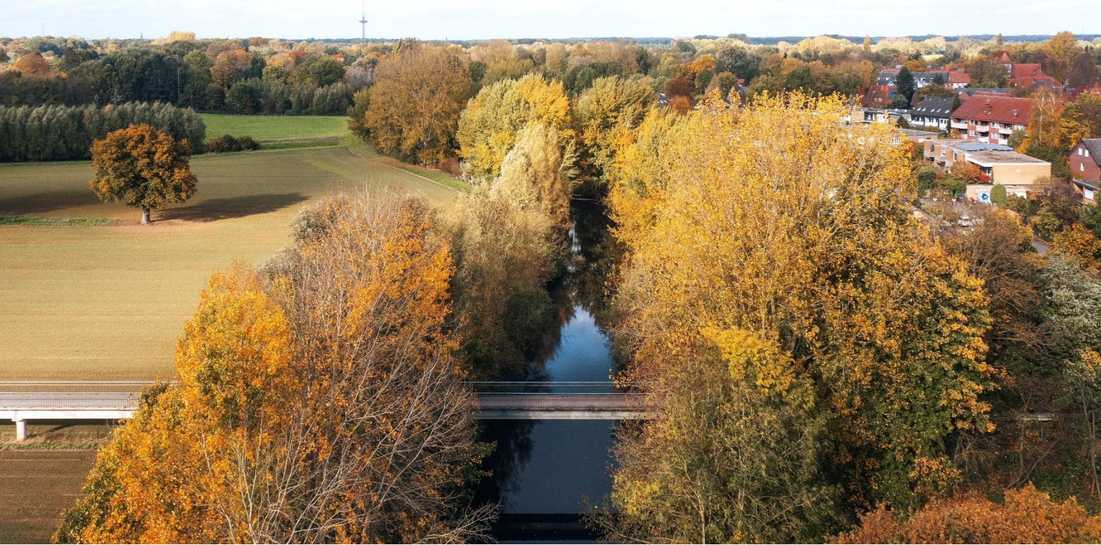
Bild 35: Blick über die Wersebrücke
