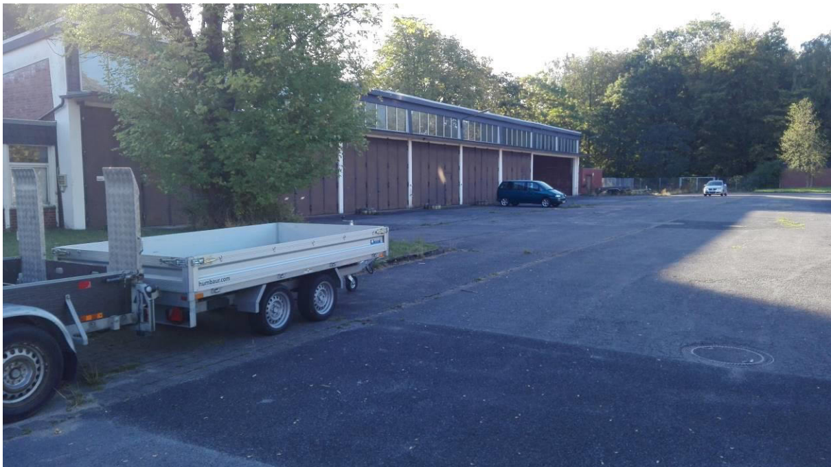
Abbildung 7: Kfz-Halle Unterstellhalle; Gebäude Nr. 11
