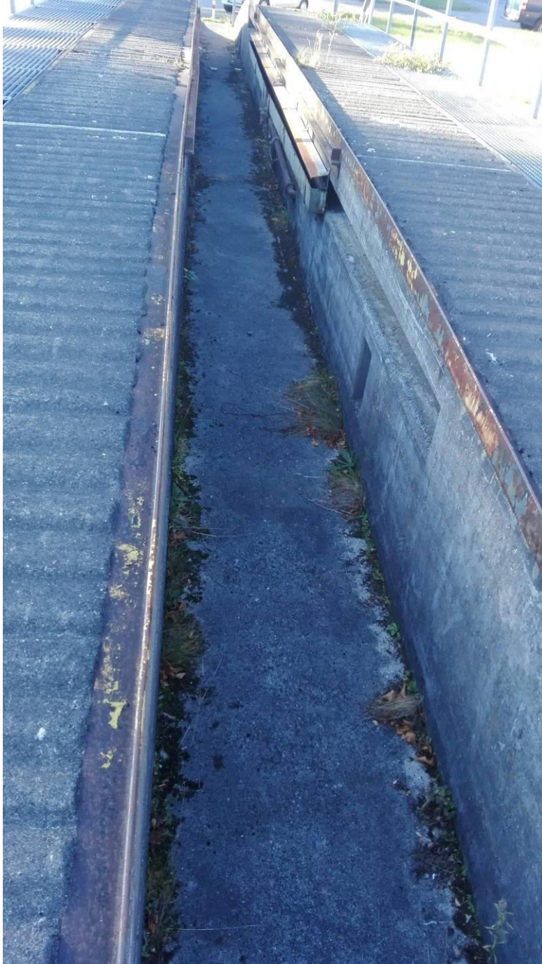
Abbildung 5b: Ehem. Abschmierrampe; Gebäude Nr. 20
