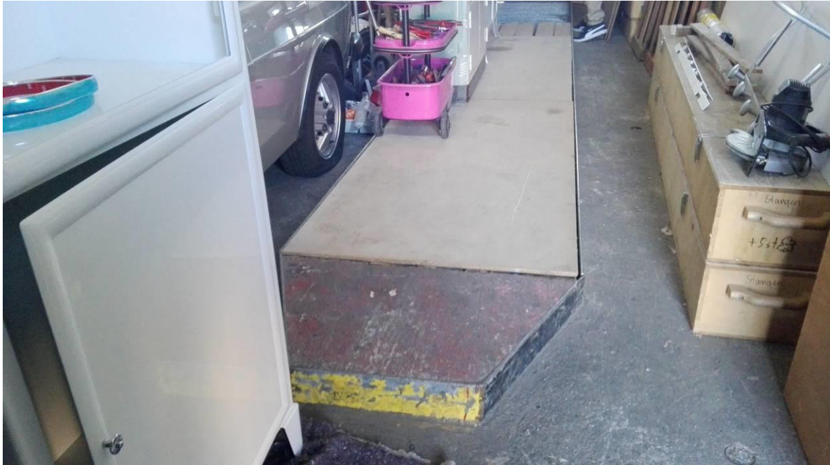
Abbildung 8: Wartungsgrube in der ehem. Waschhalle; Gebäude Nr. 21
