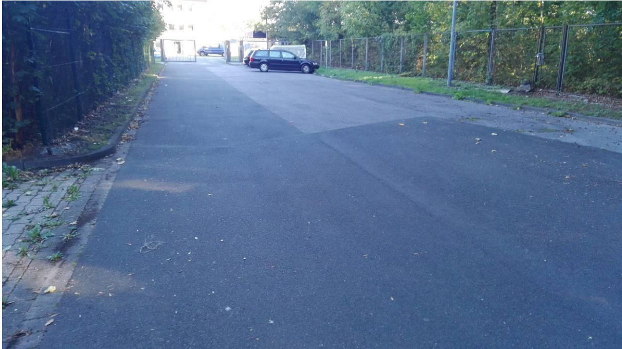
Abbildung 1: Zufahrt zur ehemaligen Truppenunterkunft von Süden
