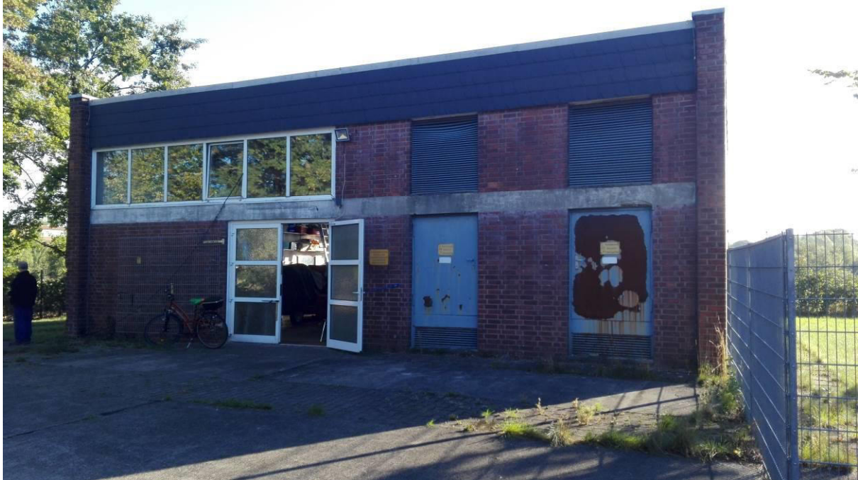
Abbildung 14: Ehem. Heizzentrale; Gebäude Nr. 15
