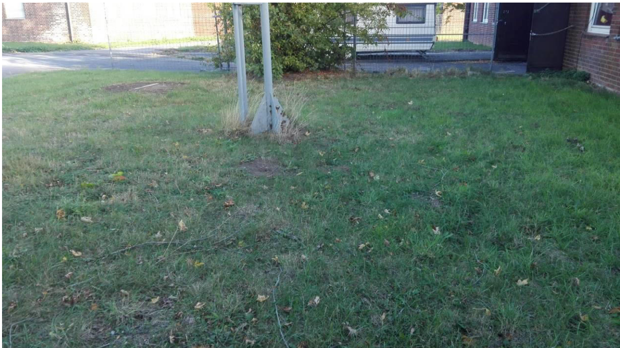
Abbildung 11: Mutmaßliche Lage der stillgelegten Benzin- und Dieseltanks (Entlüftungsrohr noch erkennbar); Gebäude Nr. 13
