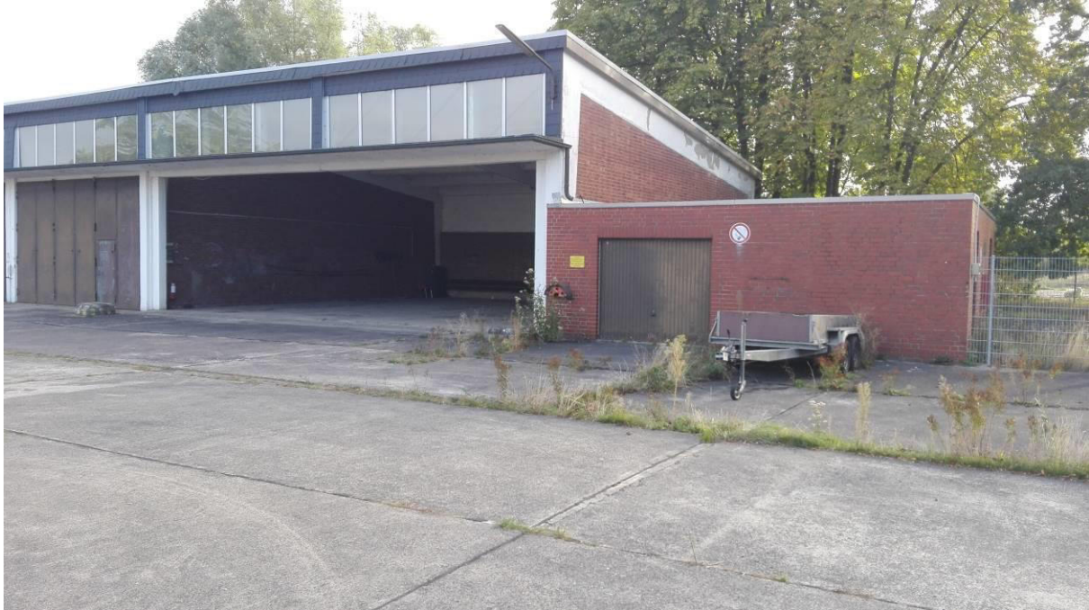
Abbildung 6: Unterstellhalle mit angrenzender Garage; Gebäude Nr. 11 + 12
