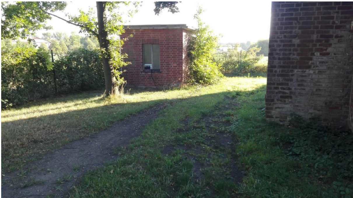
Abbildung 15: Ehem. Pumpenhaus nördlich der Heizzentrale: ehem. vermutlich Lagerung von Asche/Schlacke
