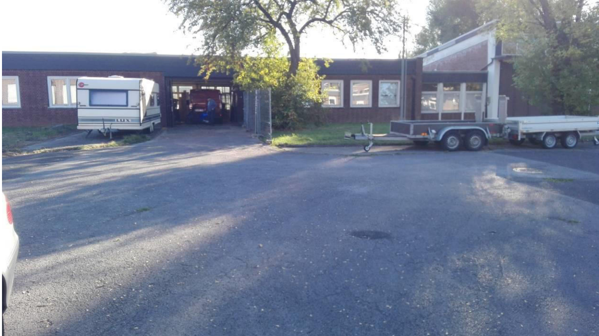
Abbildung 12: Werkstatt-/ Lagergebäude; Gebäude Nr. 14
