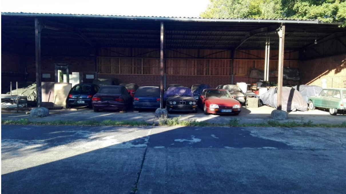
Abbildung 16: Pkw-Abstellhalle; Gebäude Nr. 16
