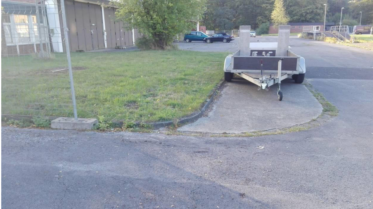
Abbildung 10: Ehem. Tankbereich; Gebäude Nr. 13
