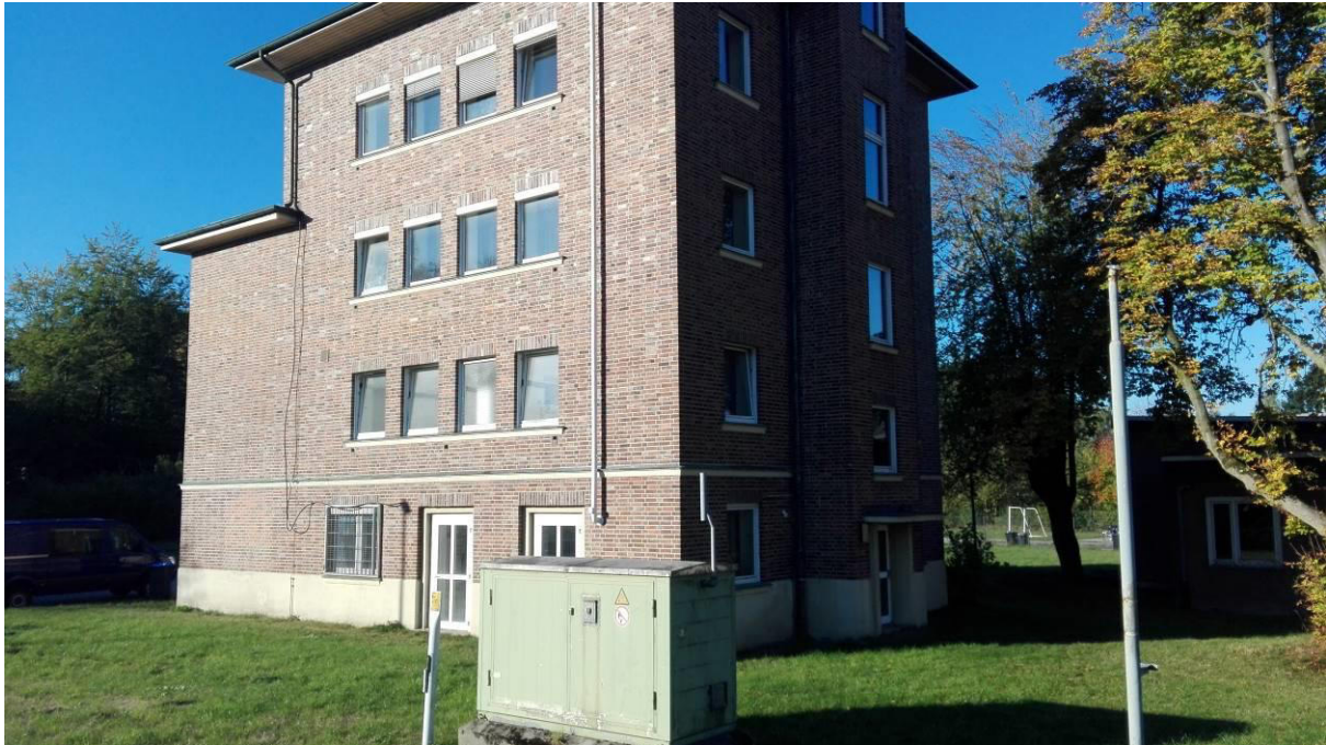
Abbildung 3: Ehem. Verwaltungsgebäude (aktuell Nutzung durch den Kampfmittelräumdienst); Gebäude Nr. 6
