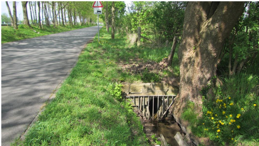
Abbildung 5: Hauptstrang: Beginn der Verrohrung bei Gew.-km 0,78
