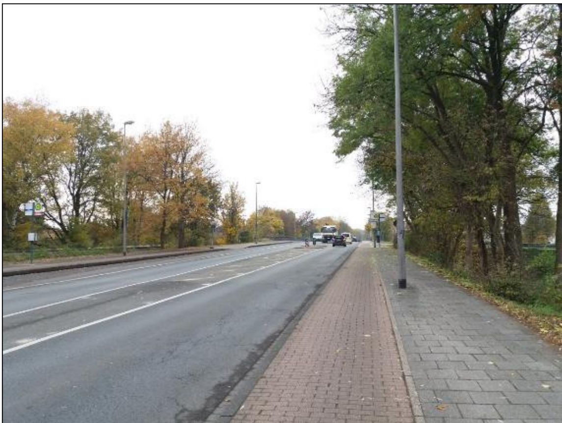
Abbildung 2: Warendorfer Straße – Blickrichtung Westen
